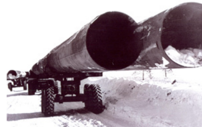
Транспортировка трубопроводов. МГНГ-НВ-8860
